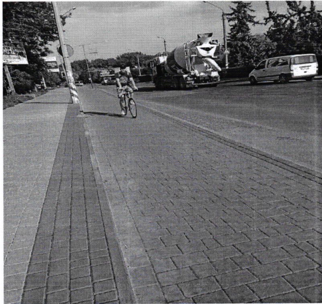
Відремонтований тротуар з велодоріжкою на вул. Галицькій
