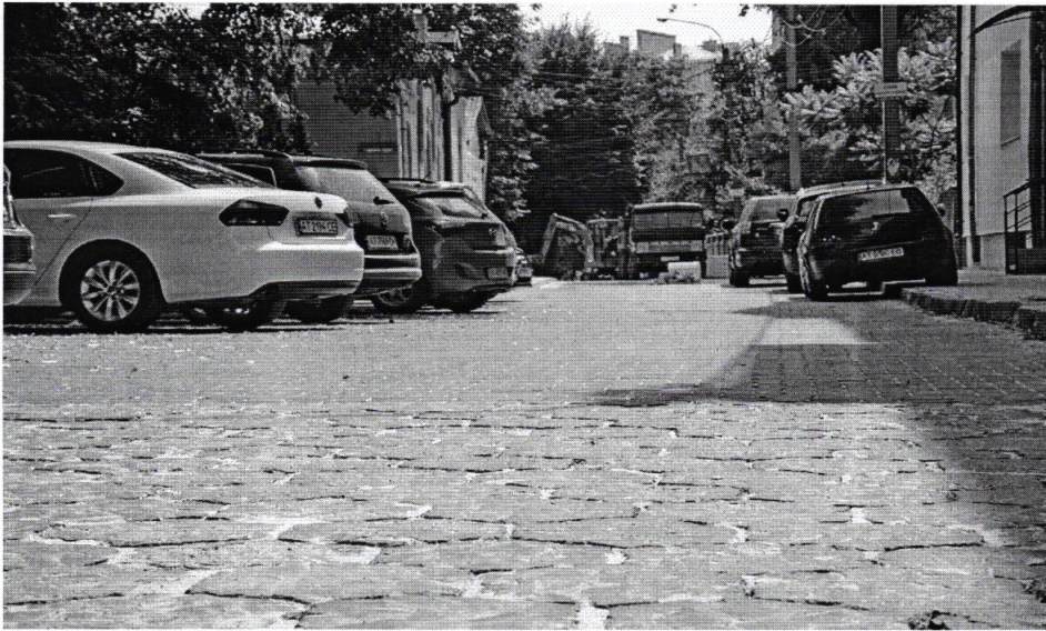
вул. Донцова після капремонту
