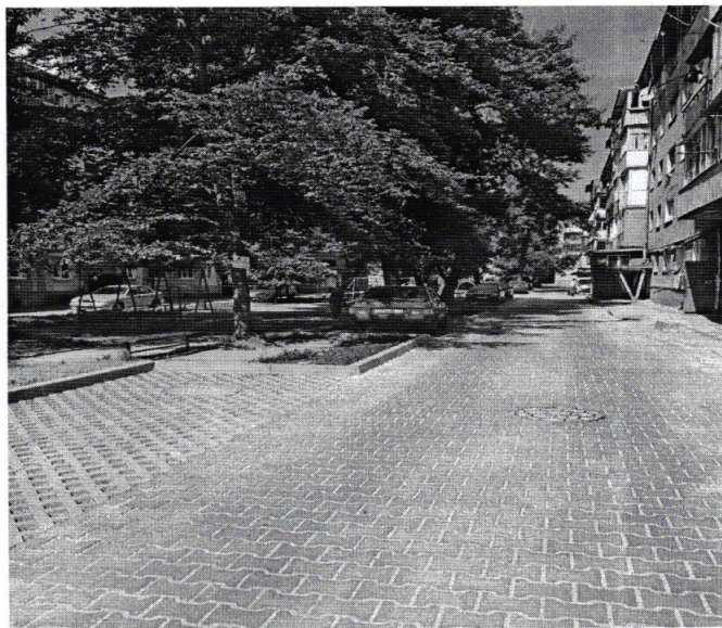
Двір на вул. Сорохтея, 16 після капітального ремонту
