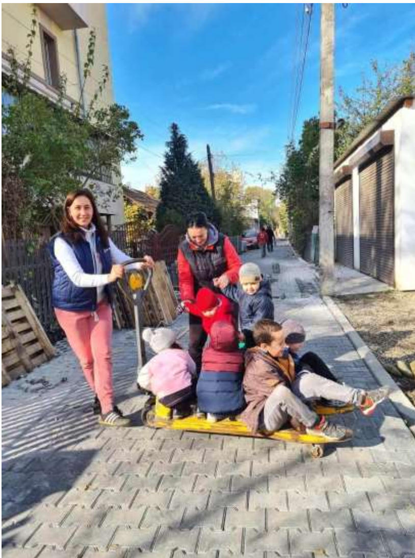
Капітальний ремонт проїзду від вул. Каменярів до вул. Миру в м. Івано-Франківську
