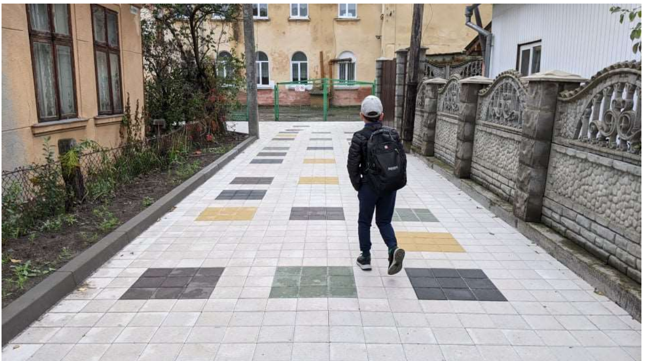
Капітальний ремонт проїзду від вул. Б.Хмельницького до ліцею № 16 в м. Івано-Франківську
