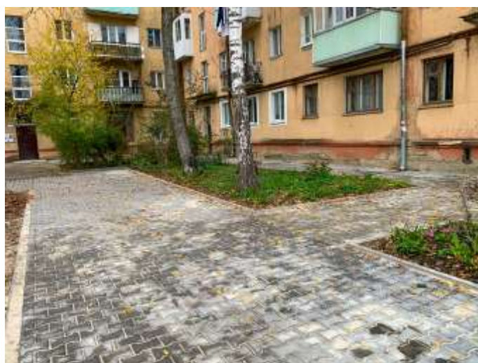
Капітальний ремонт міжбудинкових проїздів та прибудинкових територій на вул. Бельведерській, 53, 55 та вул. Вороного, 4
