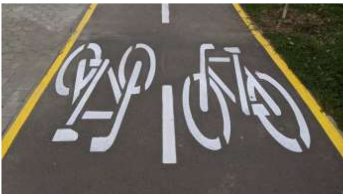
Нанесення розмітки та встановлення дорожніх знаків на велодоріжці на міському озері
