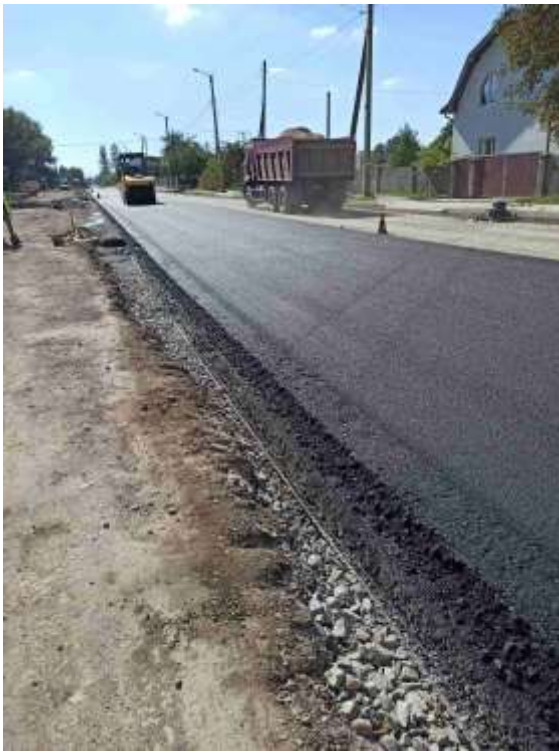
Реконструкція вул. Автоливінмашівської (від залізничного переїзду до вул. Юності)
