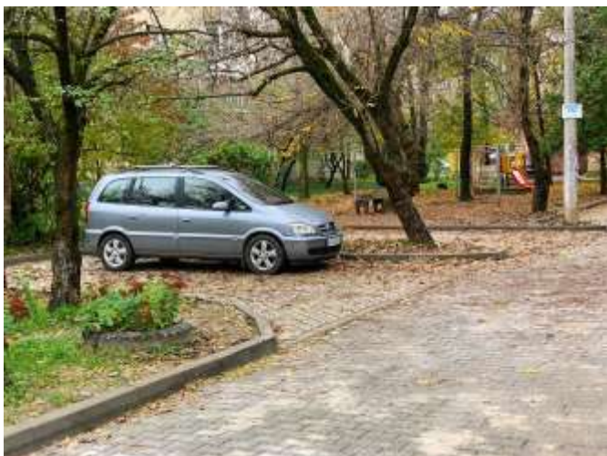
Виконання капітального ремонту міжбудинкового проїзду та прибудинкової території на набережній ім. В. Стефаніка, 4
