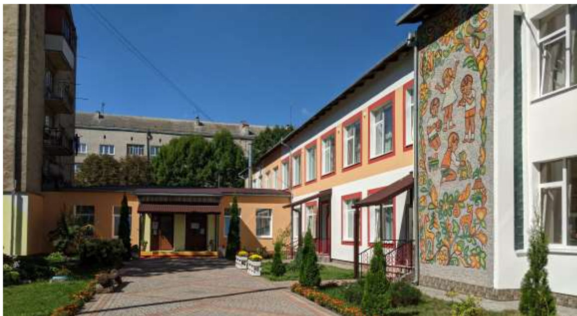
Капітальний ремонт ДНЗ №15 «Гуцулочка» по вул. Нова, 5
