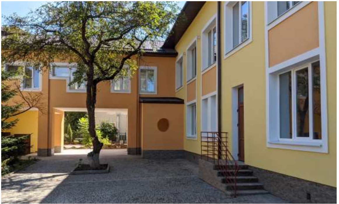
Капітальний ремонт ДНЗ №1 «Калинонька» по вул. Вовчинецька, 9
