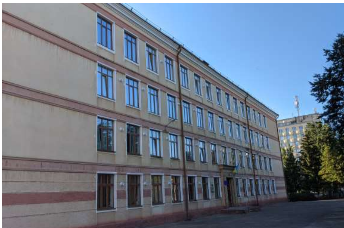
Капітальний ремонт НВК «Школа-гімназія №3» (ЛІЦЕЙ №20)
