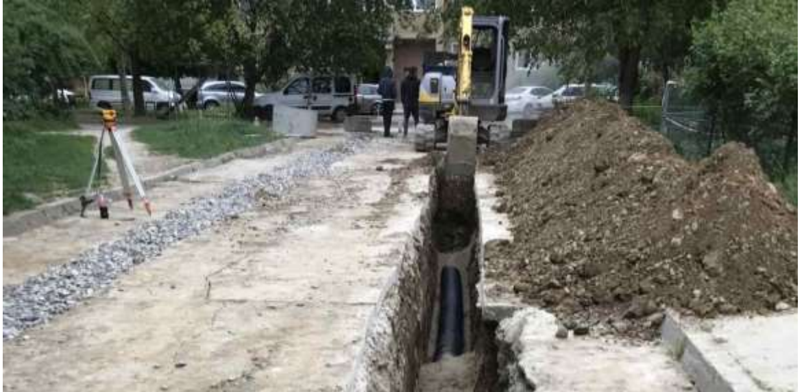
Реконструкція дворової господарсько-побутової та дощової каналізації на вул. Хіміків, 15-19
