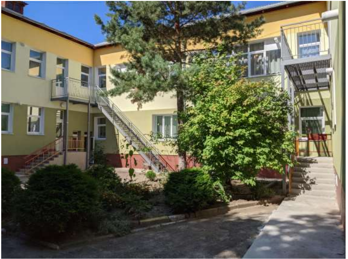
Капітальний ремонт ДНЗ №11 «Пізнайко» по вул. Ак. Сахарова, 32а
