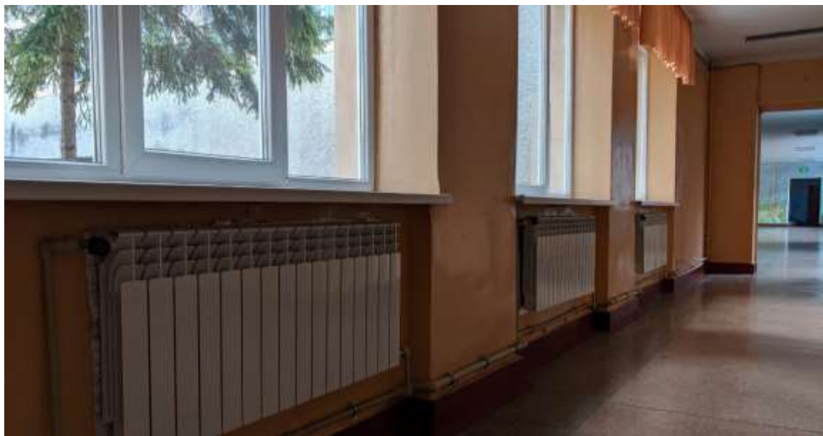
Капітальний ремонт системи опалення та встановлення ІТП в ЗШ №22 (ЛІЦЕЙ №22) по вул. Івана-Павла II, 24
