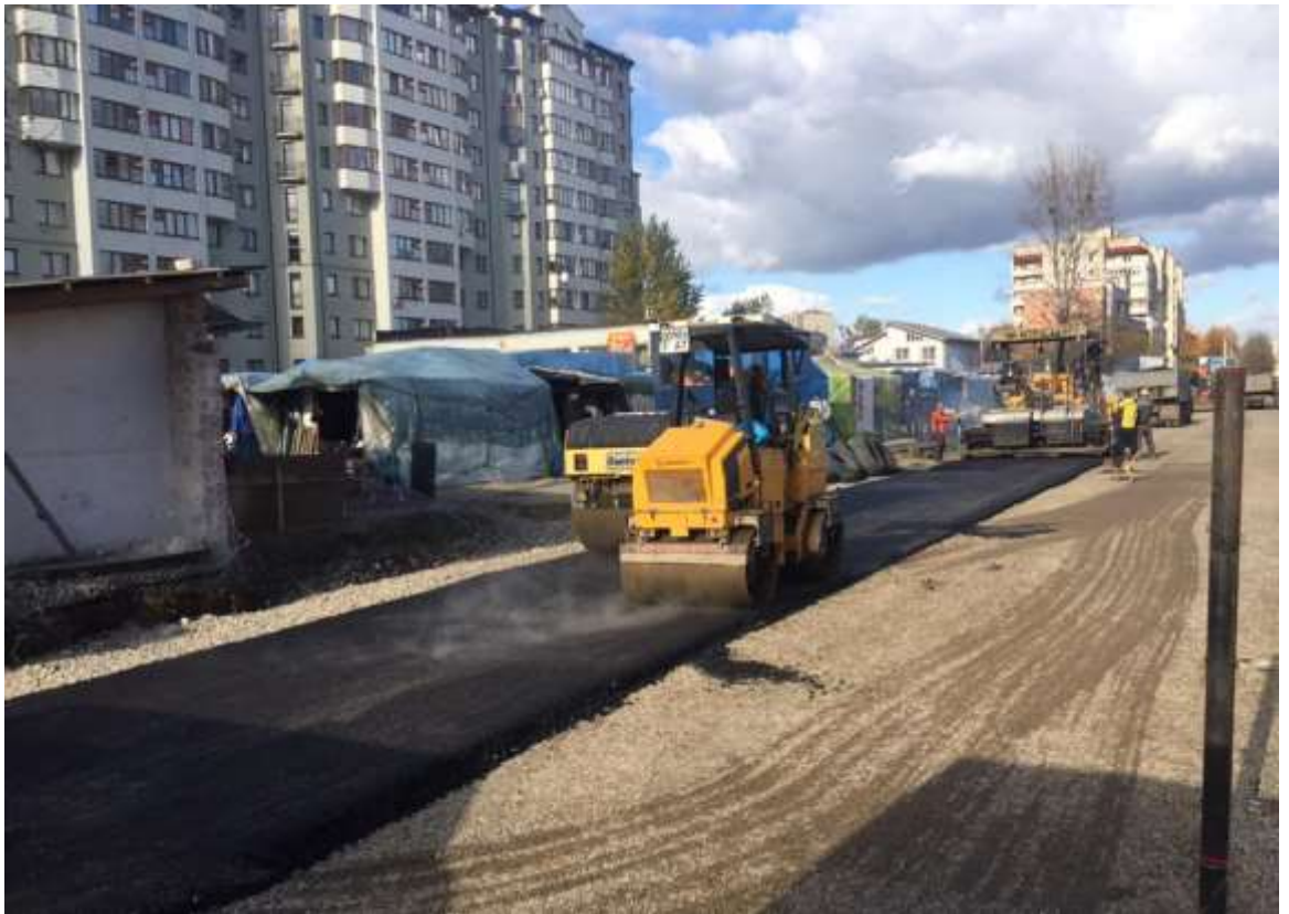
Будівництво Північного бульвару на ділянці від вул. Бельведерської до вул. Панаса Мирного
