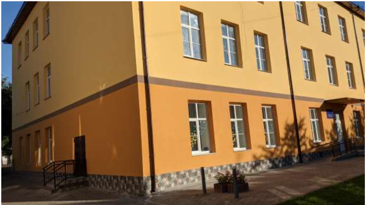
Ремонтно-реставраційні роботи корпусу №1 ЗОШ №7
