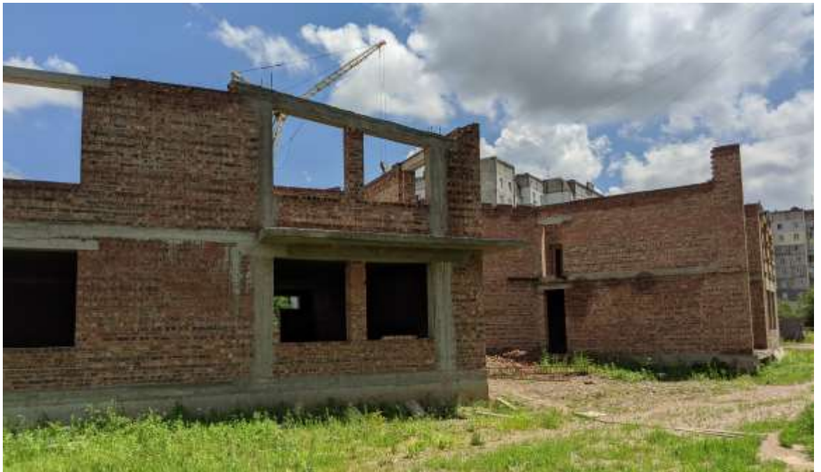
Будівництво дитячого садка в м-ні "Каскад"
