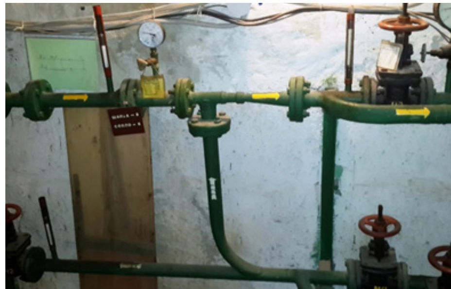
До модернізації — елеваторний вузол
