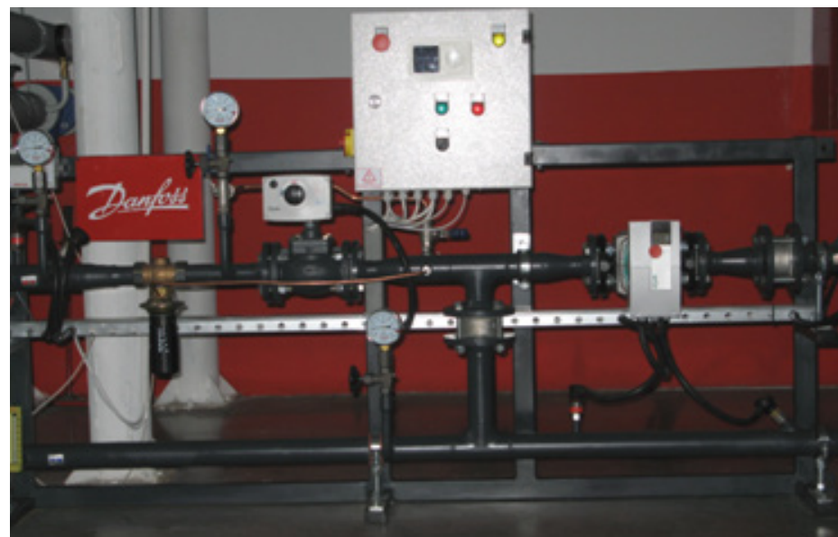
Після модернізації — індивідуальний тепловий пункт
