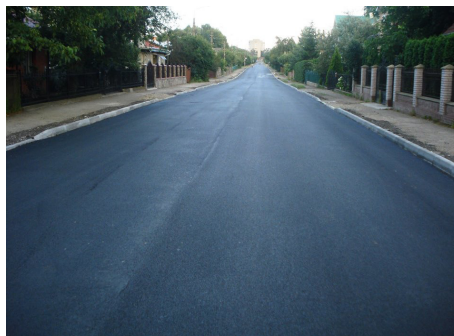
Вул. Дорошенка після капремонту
