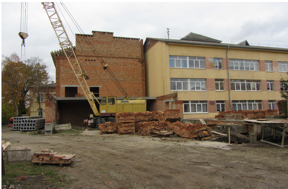
Будівництво спортивного залу ЗОШ № 16
