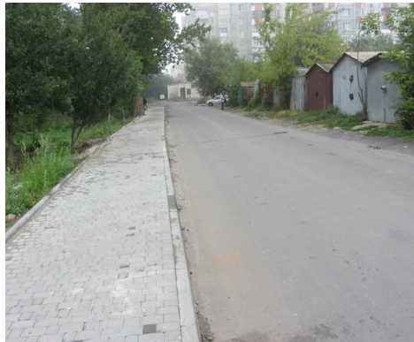
Вибірковий капітальний ремонт вул. Покутської (на ділянці від вул. Молодіжної, 40 до вул. Івасюка)
