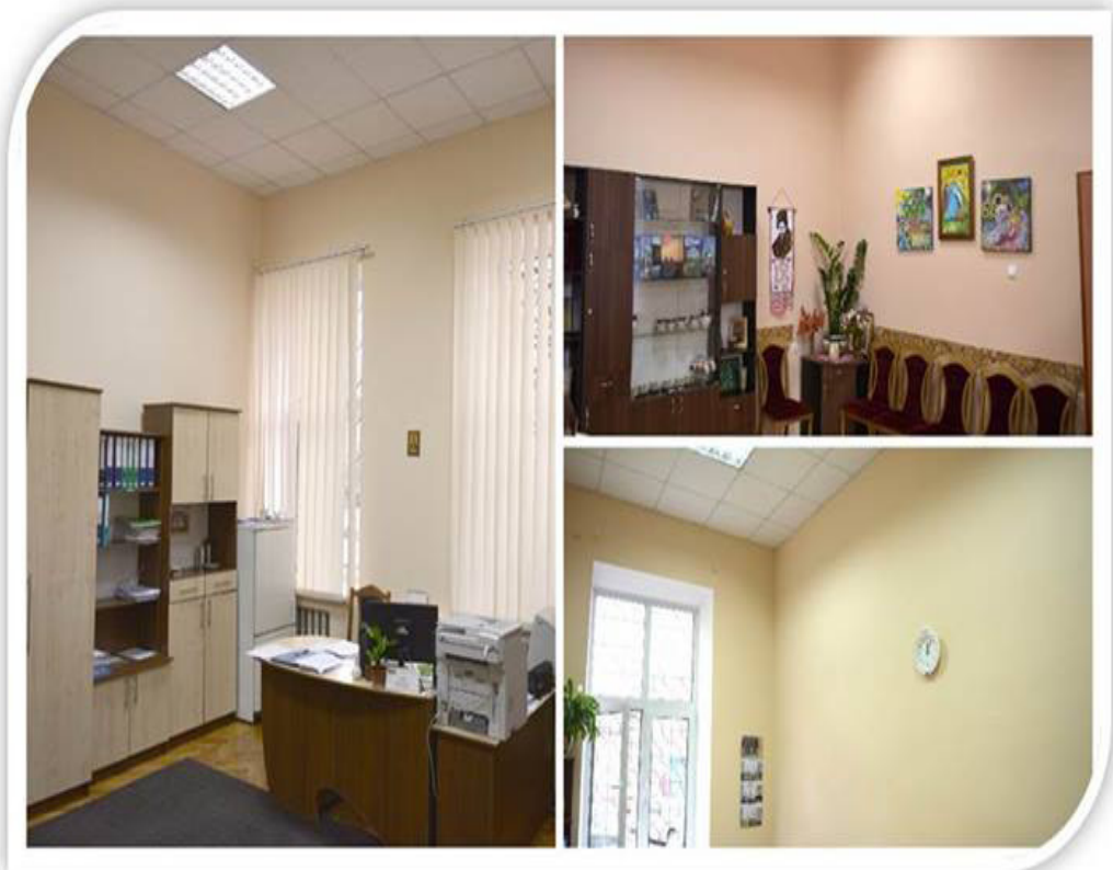
Ремонт приміщень Департаменту культури
