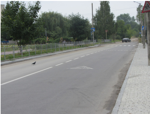
Вибірковий капітальний ремонт вул. Хіміків (на ділянці від вул. Тролейбусна до ЗШ № 4)
