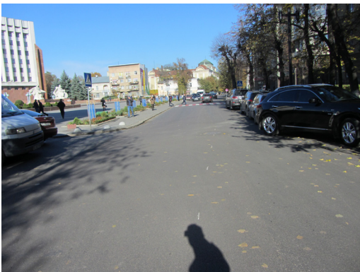
Вибірковий капітальний ремонт вул. Грушевського (на ділянці від вул. Вагилевича до вул. Гаркуші)
