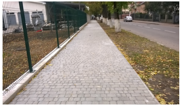
Капітально відремонтований тротуар на вул. Сорохтея
