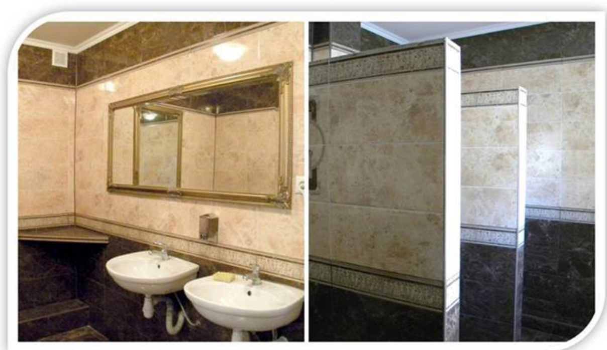
Ремонт санвузлів Центрального Народного дому
