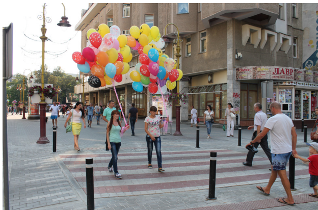
Капітально відремонтований пішохідний перехід на вул. Сотника Мартинця
