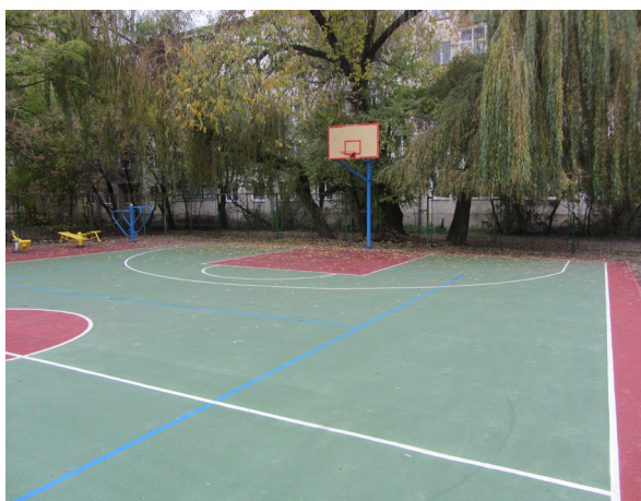
Будівництво комплексного спортивного майданчика на вул. Карпатська, 6,8
