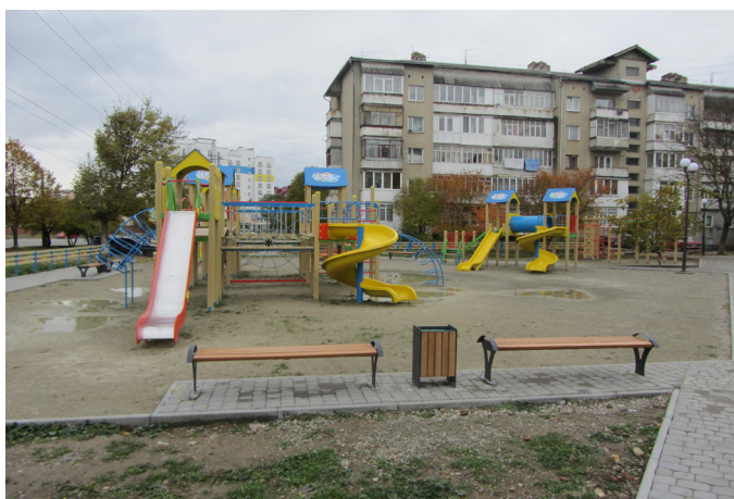
Будівництво дитячого майданчика біля житлового будинку на вул. Довженка, 8
