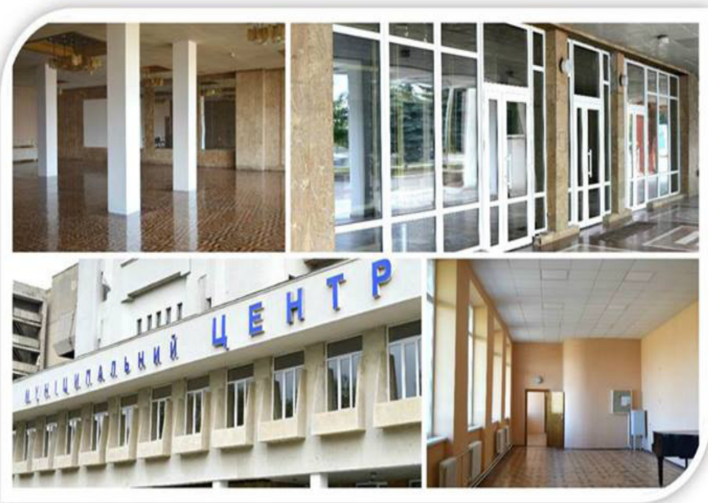
Ремонт Муніципального Центру дозвілля
