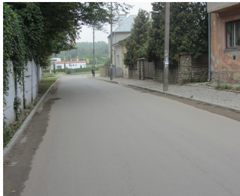
Капітальний ремонт вул. Промислової
