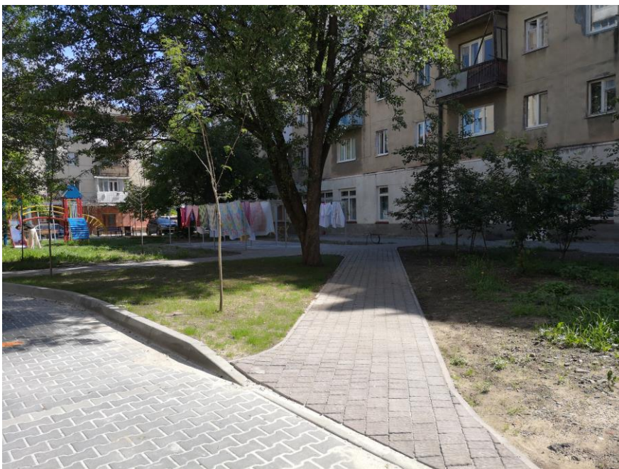
Капітально відремонтований міжбудинковий проїзд та прибудинкова територія на вул. Коновальця, 121 – Слави Стецько, 2
